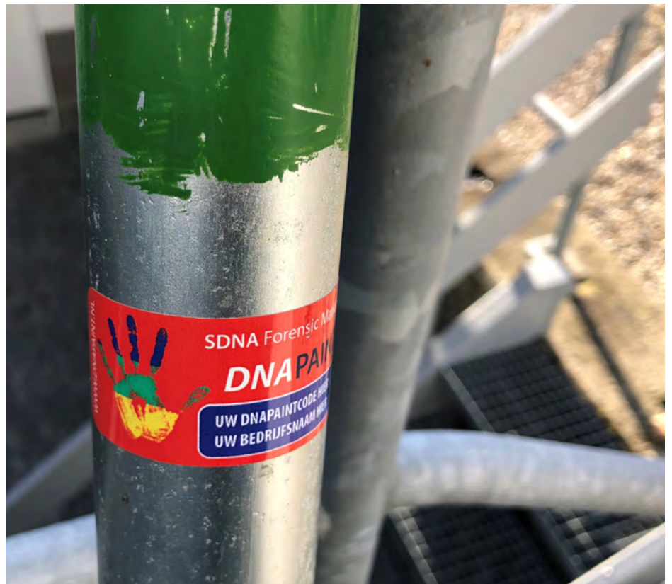
Det er meget dumt at stikke af med et stillads med et sådant mærkat. Mærkaten viser, at stilladsdelen er registreret og kan DNA-spores
